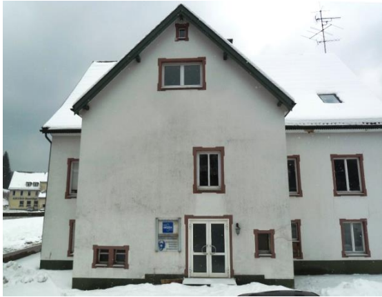
Abb. 16: heutiges ANUBA Kundenzentrum – im 1. Stock wurde 1971/72 von Hilfskräften die finess montiert
